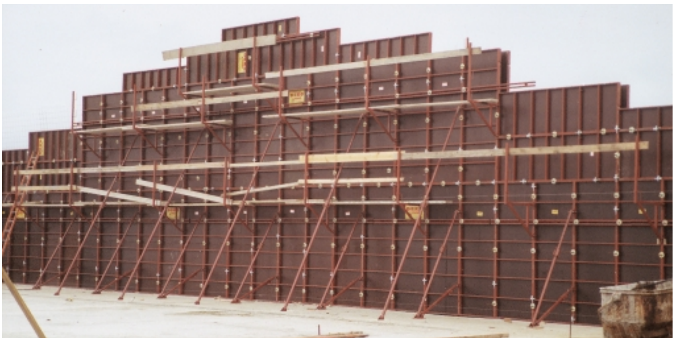
Pignon d'un local industriel ; hauteur : 6,50 m
