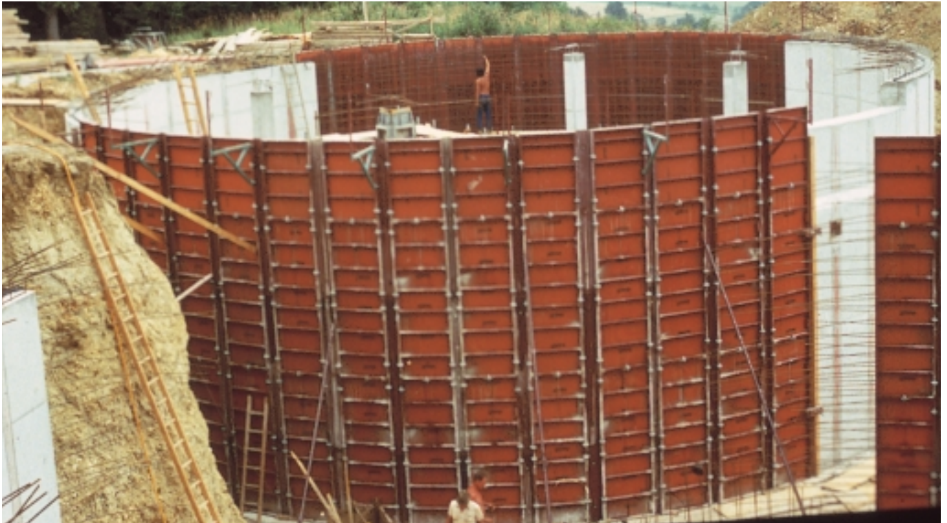
Bassin de grande capacité, hauteur coffrée 6,60 m, exécution en 4 rotations.
