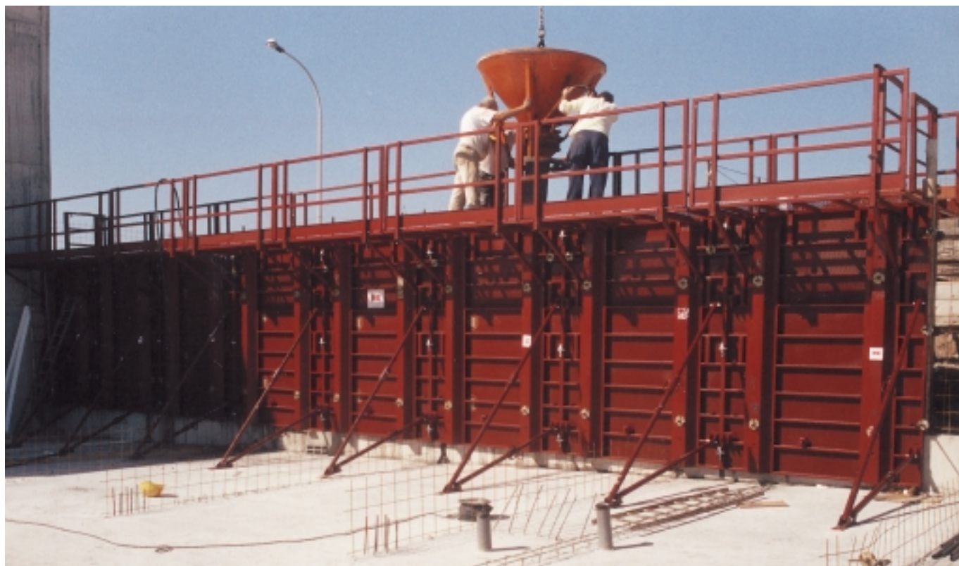
Configuration Omega avec sous hausse de 1,32 m
