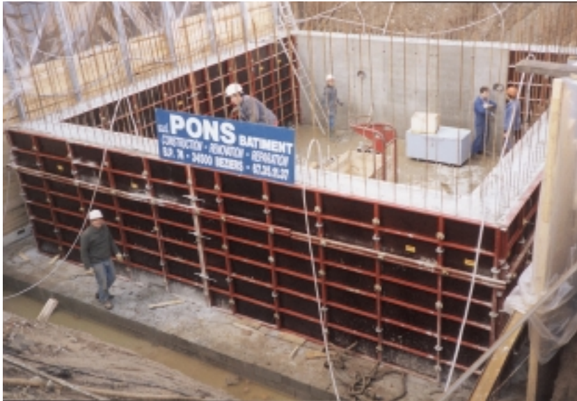
Sous-sol de villa
