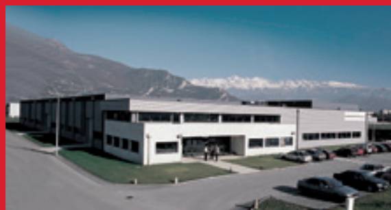
Notre usine de production à Fontaine (Grenoble)
