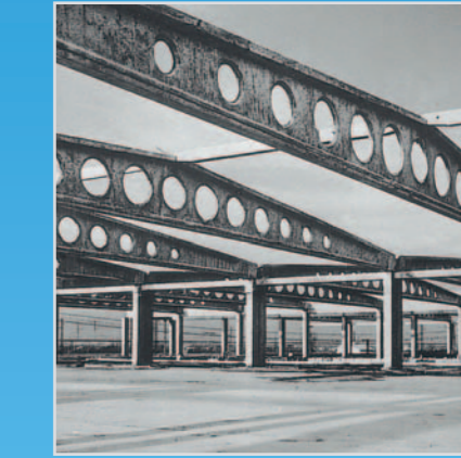
Structural beams Poutres de structure
