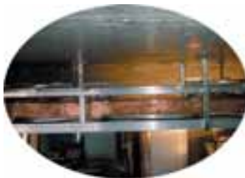
4 – Assemblage de la structure
