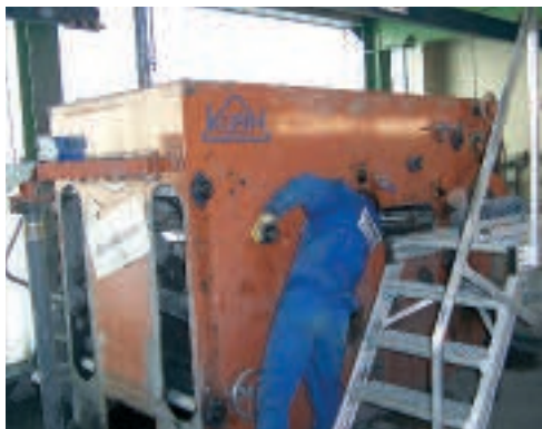
La maintenance HUBER en charge d'interventions sur des machines d'autres marques
