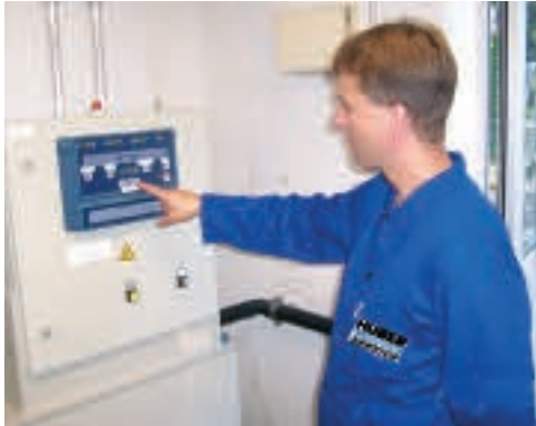
Un technicien HUBER du service montage et mise en service
