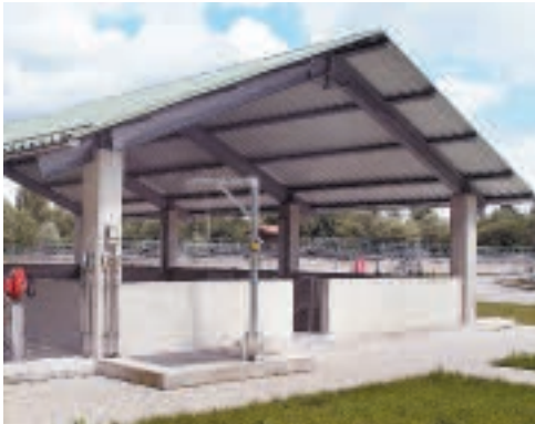
Filtre à sable CONTIFLOW® en implantation cuve béton
