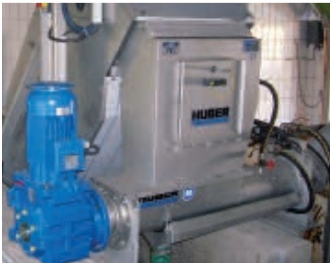
Presse laveuse de refus de dégrillage HUBER WAP couplée à un dégrilleur STEP SCREEN®
