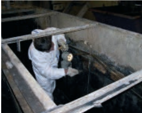
Le service HUBER de nettoyage et de rénovation
