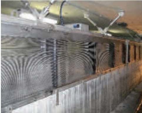
Dégrilleur placé sur la crête du déversoir
