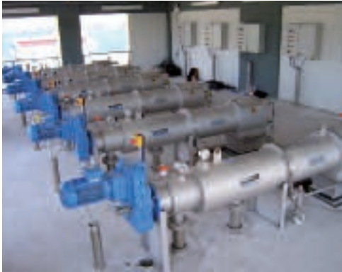
STRAINPRESS® – Tamisage continu sous pression
