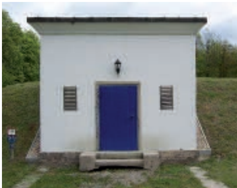
Réservoir d'eau potable avec équipements de sécurité
