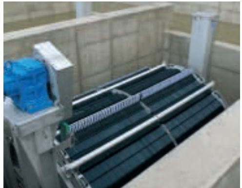
VRM® 30 – unité d'ultrafiltration installée dans un ouvrage béton d'une station d'épuration communale
