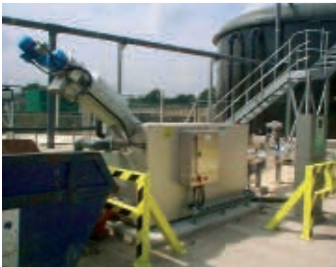
ROTAMAT® Dégrillage fin des boues
