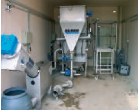
Solution compacte: tamisage 1 mm et flottation à air dissous HUBER HDF
