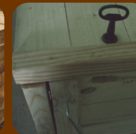
Système de verrouillage des composteurs.
