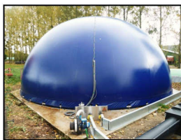
Gazomètre (stockage du biogaz)
