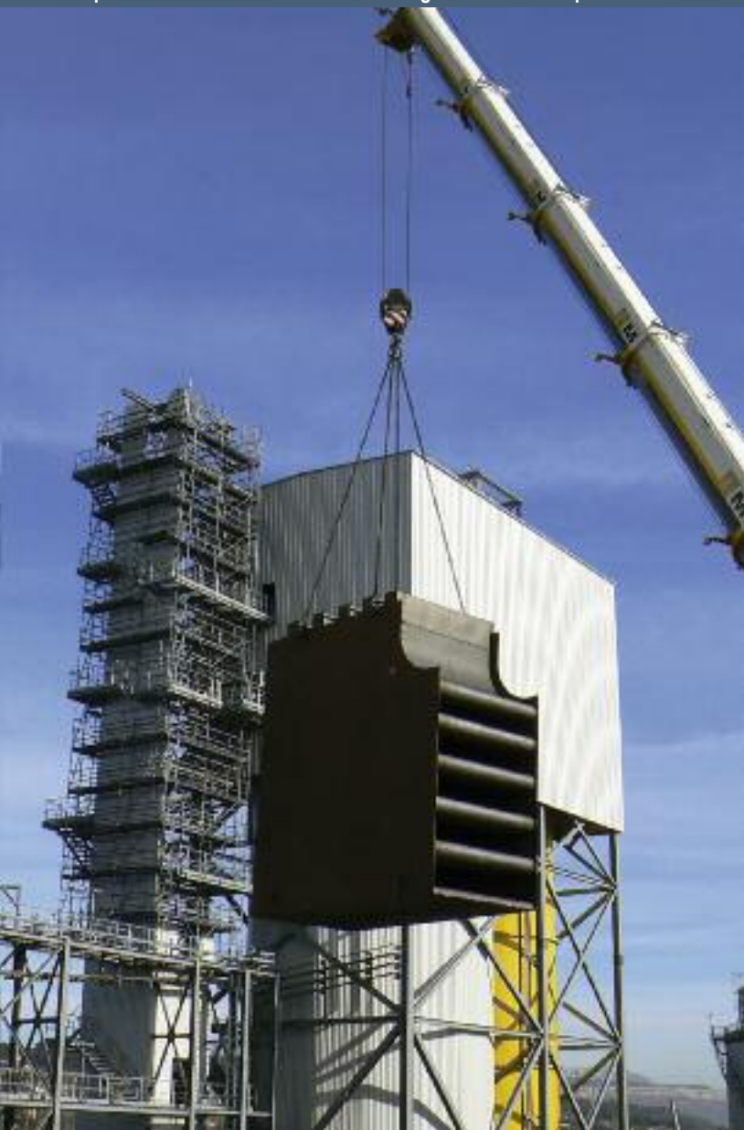
Mise en place d'un silencieux ventilateur de tirage centrale électrique 1 000 000 m³/h
