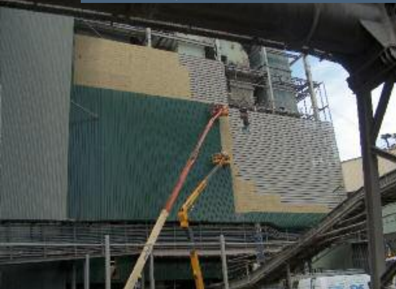
Mise en place d'un silencieux ventilateur de tirage centrale électrique 1 000 000 m³/h
