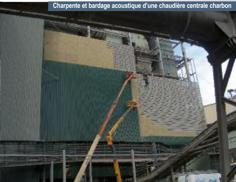
Mise en place d'un silencieux ventilateur de tirage centrale électrique 1 000 000 m³/h
