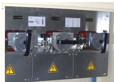
Trois Interrupteurs 3200 V
