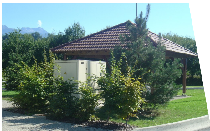
Aire de la Clusaz, alimentation aire de repos
