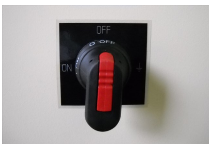
Interrupteur 950 V
