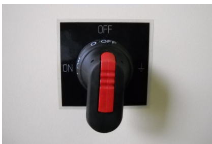
Interrupteur 950 V
