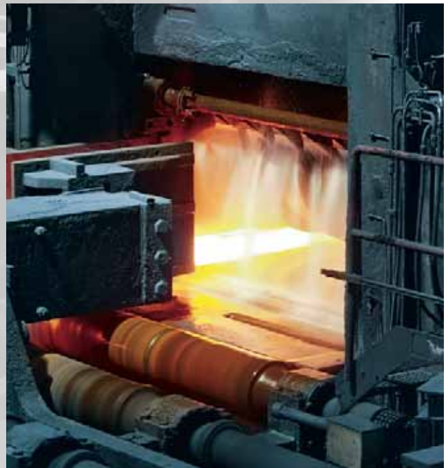
Refroidissement des circuits dans un four à induction.
